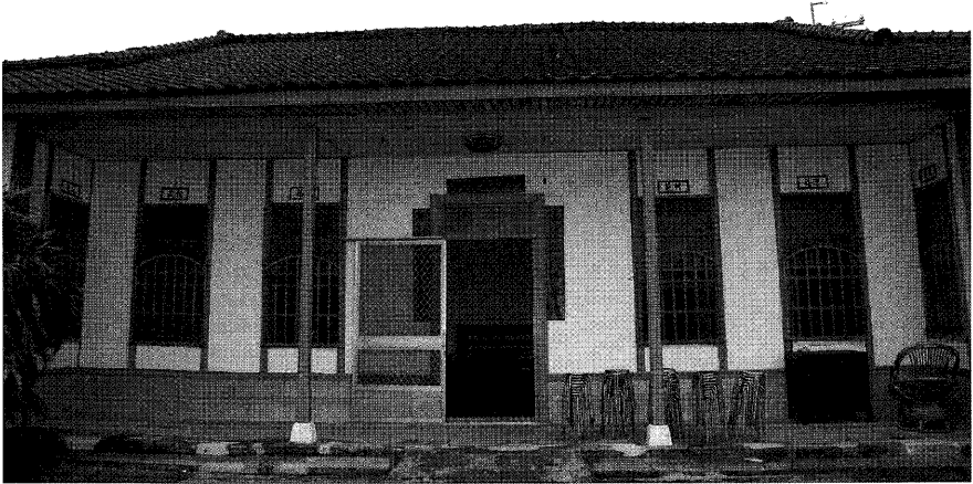
圖 16 苑裡中溝保正鄭秋厝。即使是建築正面，亦採用日本的「真壁」構造法。(2009)
